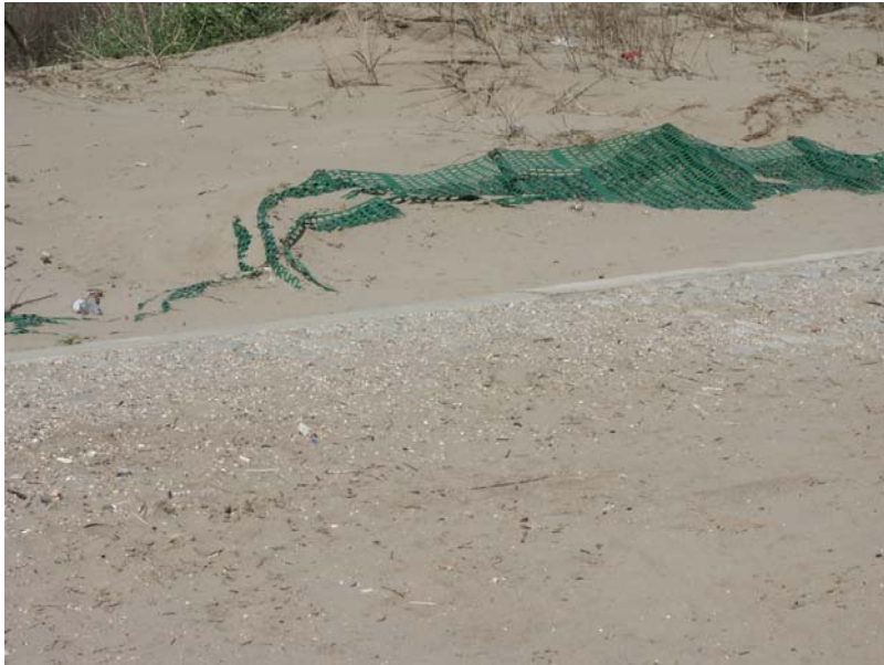
Fig. 4.4 – Il nuovo muro paraonde di Isola Verde (tratto IVB)
