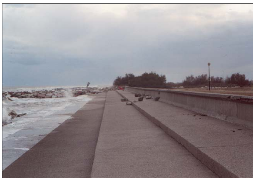
Fig. 4.9 - La gradonata presso Eraclea Mare, sulla quale sono evidenti i segni lasciati dalla mareggiata del novembre 2000 (foto Pillon)
