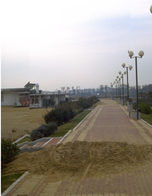
Fig. 2.4 – La “falsa duna“ di Bibione, costruita in tempi recenti a difesa della porzione urbanizzata del litorale.
